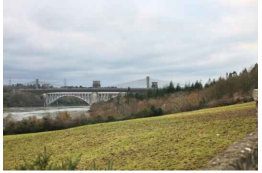
PONT ECSTRADOS UN LLED EXTRADOS ONE-SPAN BRIDGE
