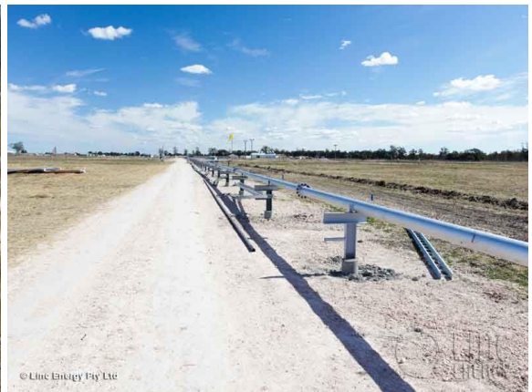
Ffigur B9 Piblinell trosglwyddo uwchlaw'r ddaear 2011, Chinchilla, Linc Energy (Ilun, Linc Energy)
