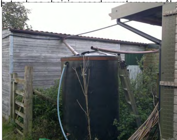
Holsworthy Organics, Dyfnaint: caiff dŵr glaw ei gasglu oddi ar doeau a'i storio mewn cynwysyddion o dan ac uwchben y ddaear.
