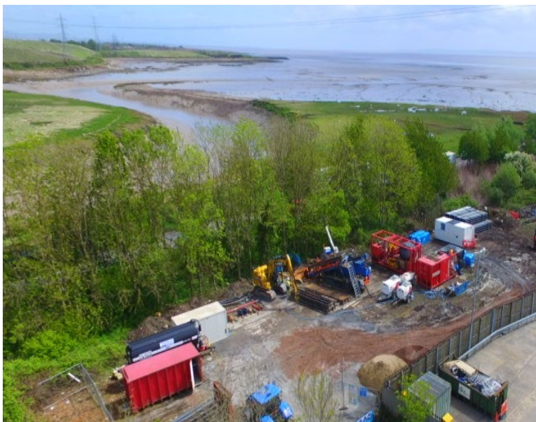
Ffigur 3 - Gwaith Drilio Cyfeiriadol – safle mynediad yn aber Afon Rhymni yn cysylltu fferm solar Lamby Way â Dŵr Cymru
