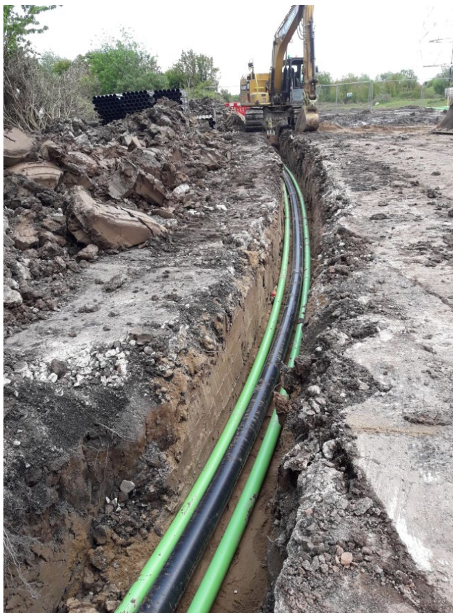
Ffigur 2 - Dwythellau a osodwyd mewn Lleoliad Dril Lansio, Lamby Way, Cyngor Sir Caerdydd
