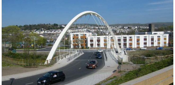
St Tydfil's Bridge, Merthyr Tydfil
