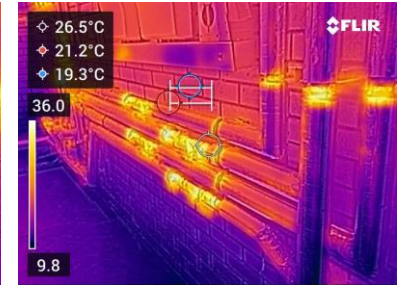
Mae inswleiddio thermol ar goll ar y bracedi a falfiau gyda cholledion gwres a gwastraff cysylltiedig. Nodwyd bod inswleiddio allanol trwy 'armaflex' gradd ddomestig ac mae bracedi ar ddangos yn peri i ormod o wres gael ei gollu.
