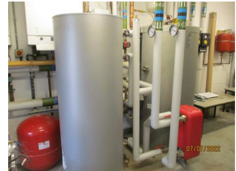
Silindrau gwasanaeth dŵr poeth a solar thermol
