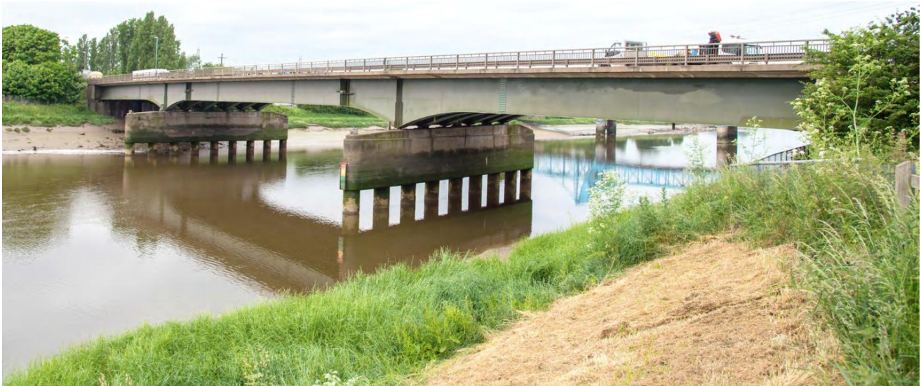
Ffigur 4: Y bont bresennol dros afon Dyfrdwy ar yr A494 (Ffynhonnell: Mott MacDonald)
